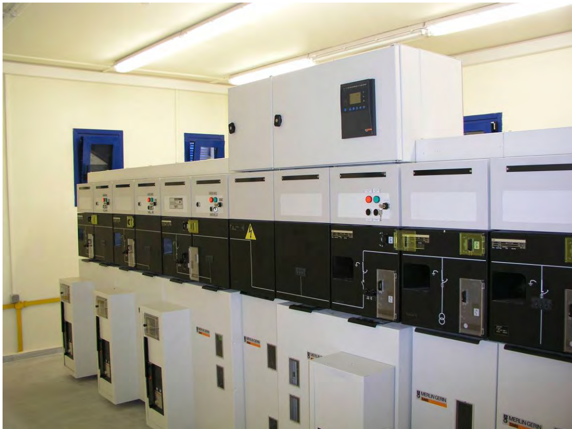
Τυπικός υποσταθμός Μ.Τ. 0,4/15 kV
